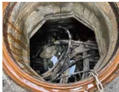
長期的に水没状態にある電線
