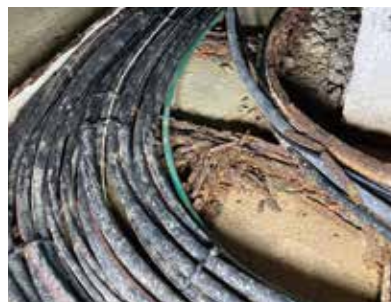
電線を置くためのラックが腐食
