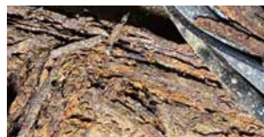
電線を置くためのラックが腐食
